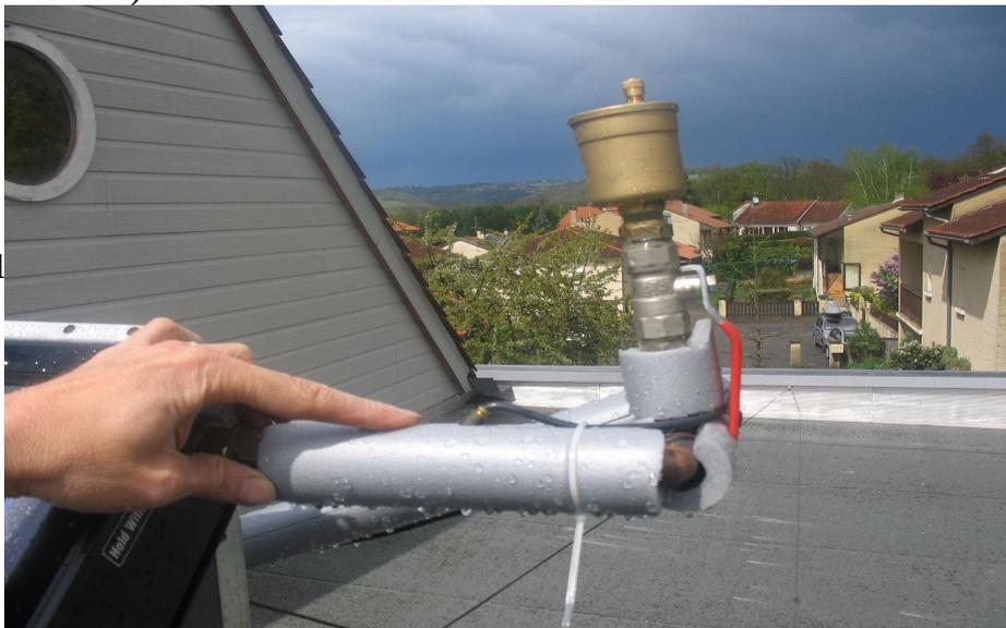
du 10 pour y placer la sonde, on pourrait la mettre directement dans le capteur en perçant un trou dans le châssis du capteur. Ensuite, je suis repassé en 18 pour mettre le purgeur en point haut qu'on peut condamner d'une fois que le circuit est purgé avec une vanne. Après, le travail consiste juste à cheminer entre le groupe de transfert et les capteurs.
