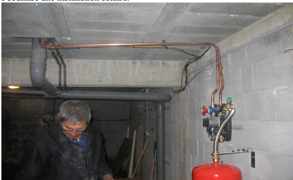
Ici sur la photo avec mon père qui est venu m'aider et apprendre le chauffage. Les tubes montent dans une gaine technique prévue lors de la construction de la maison et qui sert aussi au passage des évacuations d'EU, etc. Ils arriveront dans les combles non aménagés (toiture photovoltaïque).
