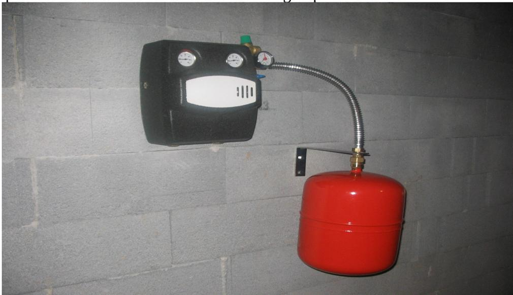
Groupe de transfert: Circulateur (pompe), groupe de sécurité solaire (soupape et vase d'expansion à raccorder), thermomètres aller et retour, manomètre, purgeur vanne de réglage de débit et débitmètre.
